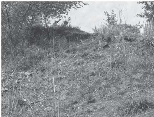
Figura 5. Deslizamiento en las vecindades de La Avellana.
